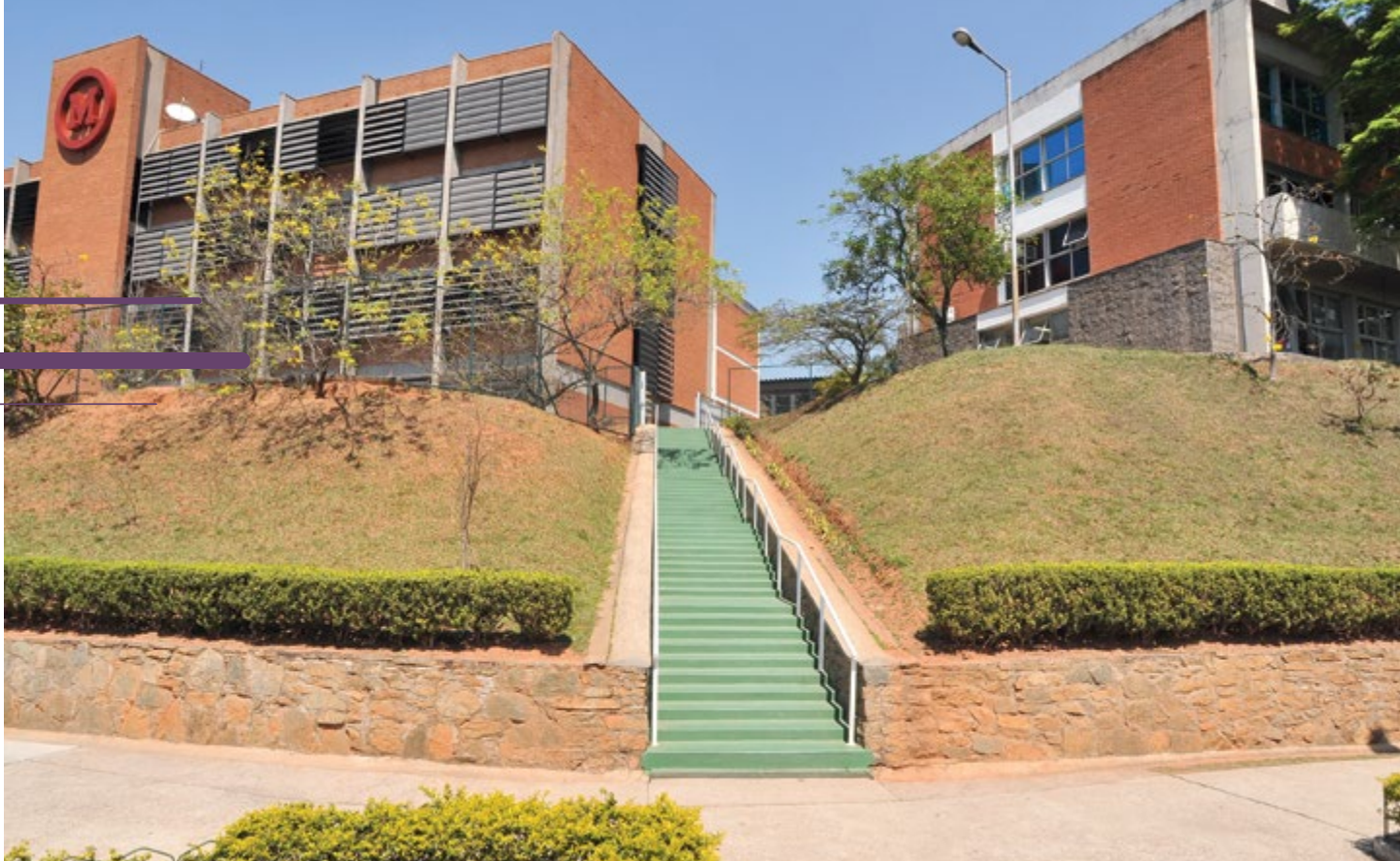
Instalações do campus Rev. Boanerges Ribeiro – Barueri
