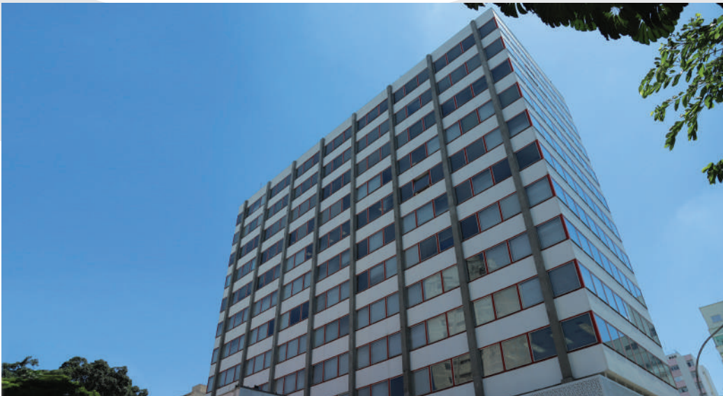
Fachada do prédio João Calvino
