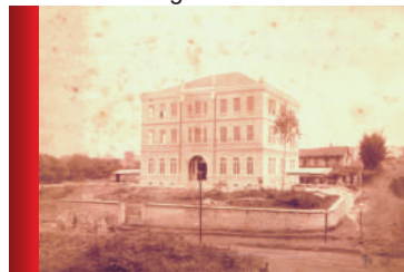
O edifício John Theron Mackenzie em seus últimos estágios de construção. 1895 - Acervo CHCM
