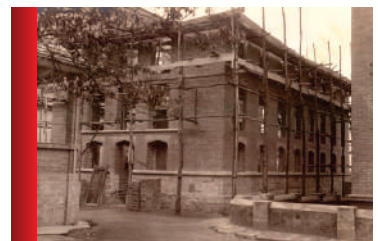
O edifício George Alexander (atual prédio 2) sendo construído. 1924 - Acervo CHCM
