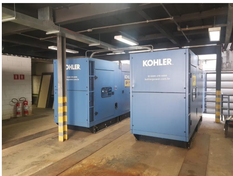
Figura 16: Geradores redundantes
