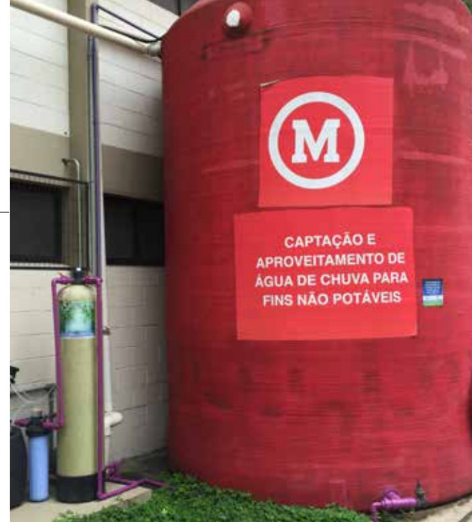
Reservatório de água de chuva do campus Higienópolis
